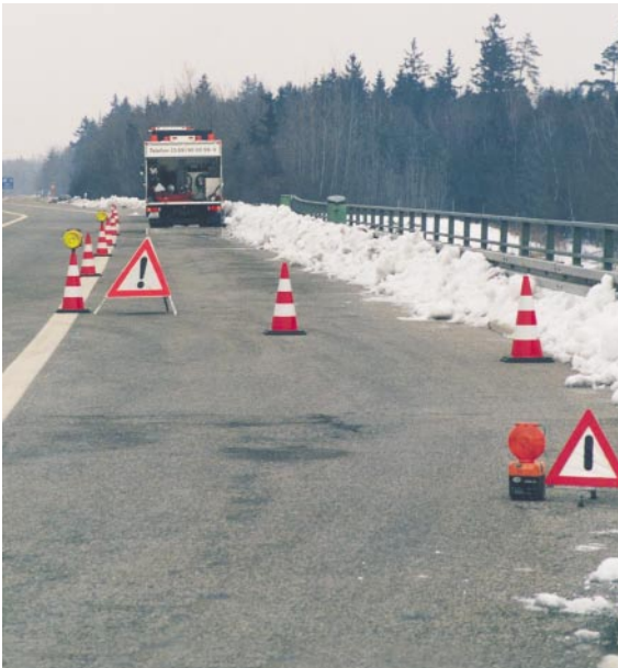
Bild 6: Absicherung einer Einsatzstelle (durch Zoomwirkung verfälschte Abstände)
