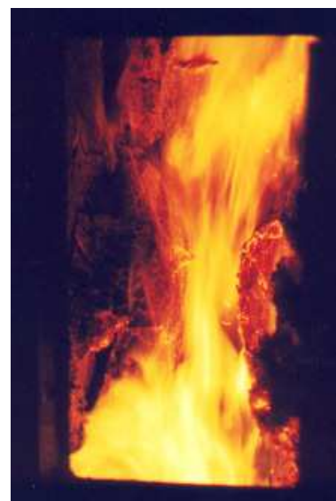
Bild 4 und Bild 5 : Rußbrand im Kamin bei geöffneter Reinigungstür
